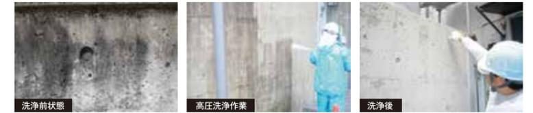
撥水材塗布は洗浄後の状況そのままの仕上がりととなります。高圧洗浄で十分に洗浄しても右上の写真のように、コンクリート内部に侵食してしまった汚れは取りきれません。
