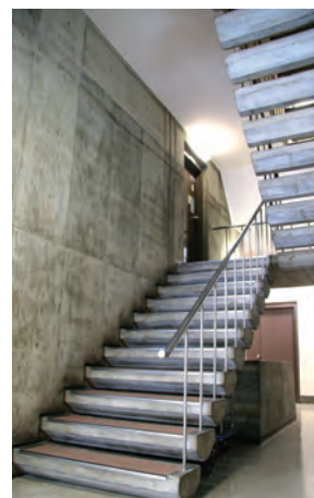
エントランス部分は、あえて以前のコンクリートを無塗装で活用。歴史の跡を残した重厚なムードで、訪れる人々を出迎えています。
